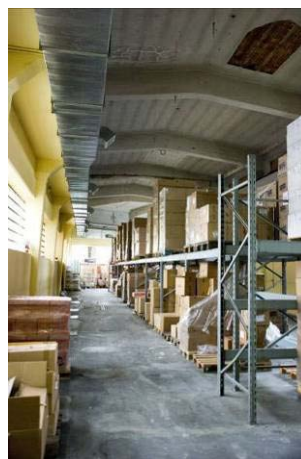
Fig.14.6 Tetto e pavimentazioni irregolari
